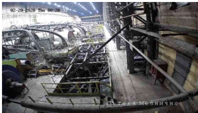
Мachinery hall «Мелнично»
